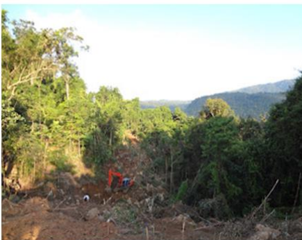
Gambar 2.1. Pembukaan trase jalan (sumbar.antaranews.com, 2017)
