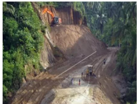
Gambar 2.1. Pembukaan trase jalan (sumbar.antaranews.com, 2017)
