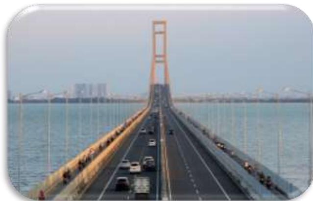
Gambar 1. 9 Jembatan Suramadu Sumber: antaranews.com
