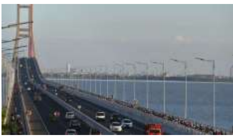
Gambar 1. 3 Jembatan Baja Sumber: jatim.antaranews.com
