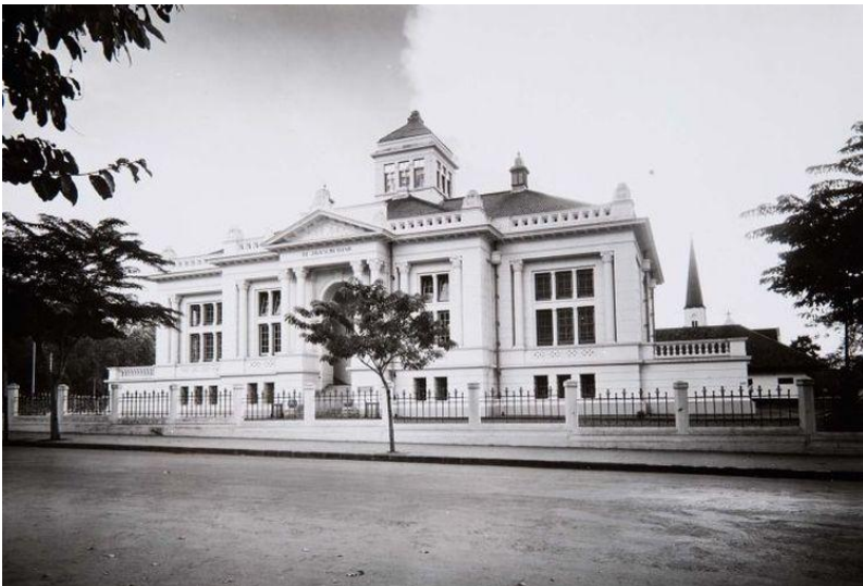
Gambar 2.1. Gedung De Javasche Bank di Bandung tahun 1918.
