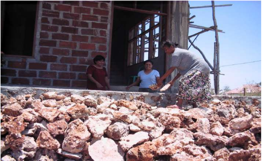
Gambar 47. Ibu Saekoko, ibu Hermanto, Eta, mereka kerja gotong royong menguruk pondasi koridor sesuai batas patok yang dibagi per rayon
